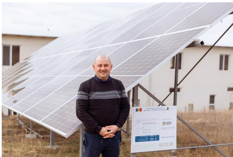
Figura 6. Instalarea panourilor fotovoltaice în cadrul Programului LEADER, SRL Voloceai Nichita, s. Colibași
